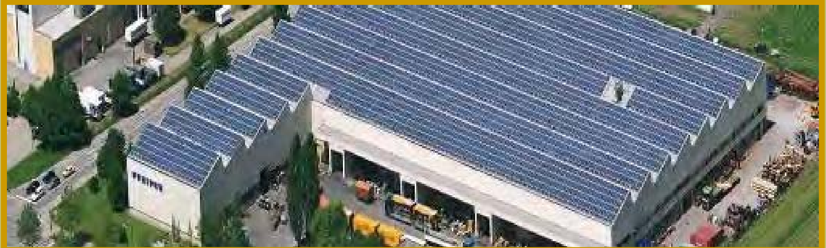
Ενσωμάτωση Φ/Β σε βιομηχανική στέγη
