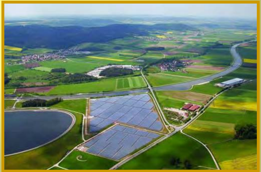
Φ/Β σταθμός ηλεκτροπαραγωγής μεγάλης κλίμακας
