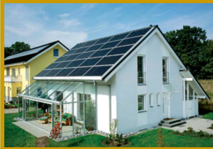
Ενσωμάτωση Φ/Β σε στέγες κτιρίων
