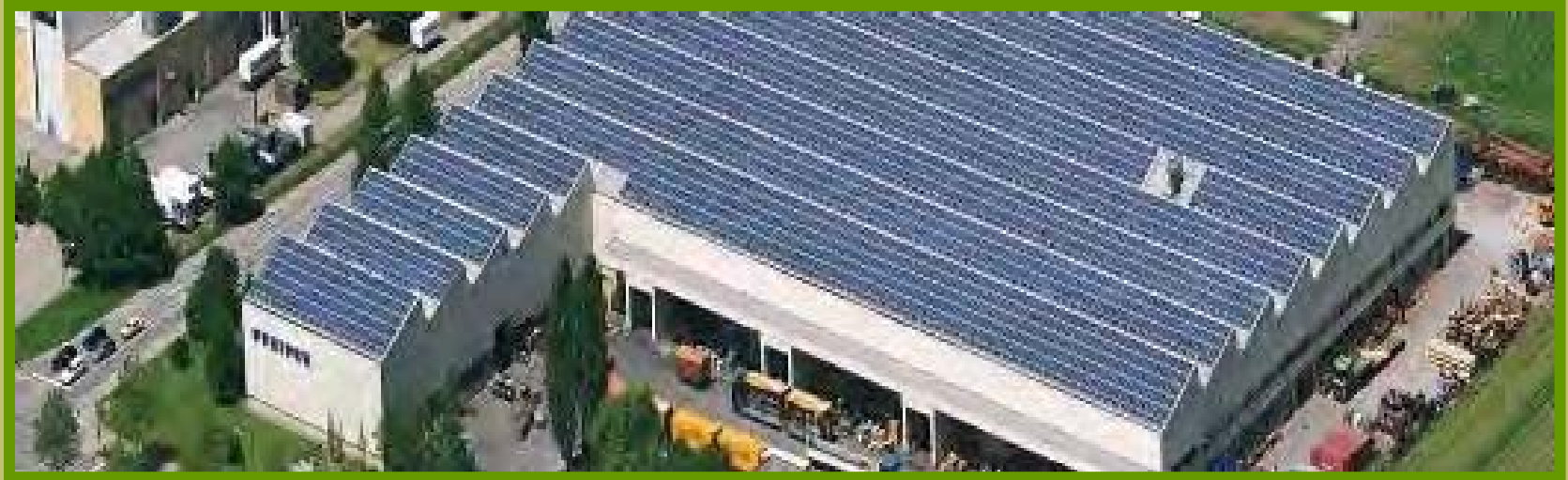
Ενσωμάτωση Φ/Β σε βιομηχανική στέγη
