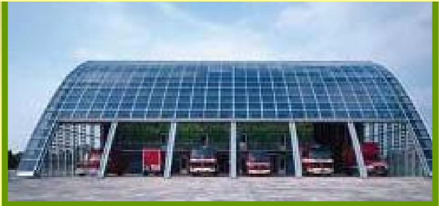
Ενσωμάτωση Φ/Β σε πυροσβεστικό σταθμό
