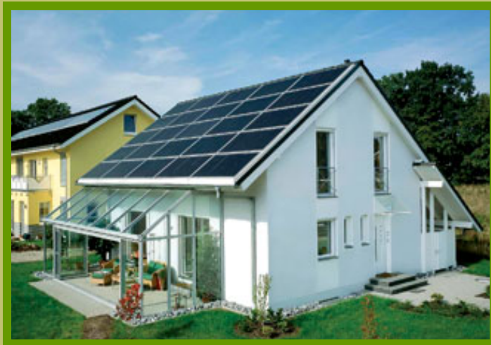
Ενσωμάτωση Φ/Β σε στέγες κτιρίων
