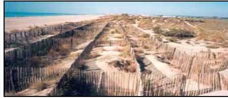
Εικ.24. Valras (Hérault,Languedoc), Έργα προστασίας ακτογραμμής, Valras (Hérault,Languedoc), works of protection of the shoreline, Εικ.25. Orpellières, (Hérault, Languedoc), Επανασύσταση σειράς αμμοθινών. Orpellières, (Hérault, Languedoc), Recreation of rows of sand dunes ΠΗΓΗ-SOURCE: 1: 40.
