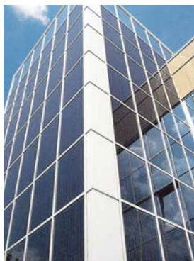
Εφαρμογή φωτοβολταϊκών σε πρόσοψη κτιρίου
