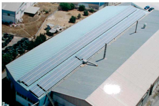
Εφαρμογή φωτοβολταϊκών σε στέγη εργοστασίου στην Κρήτη
