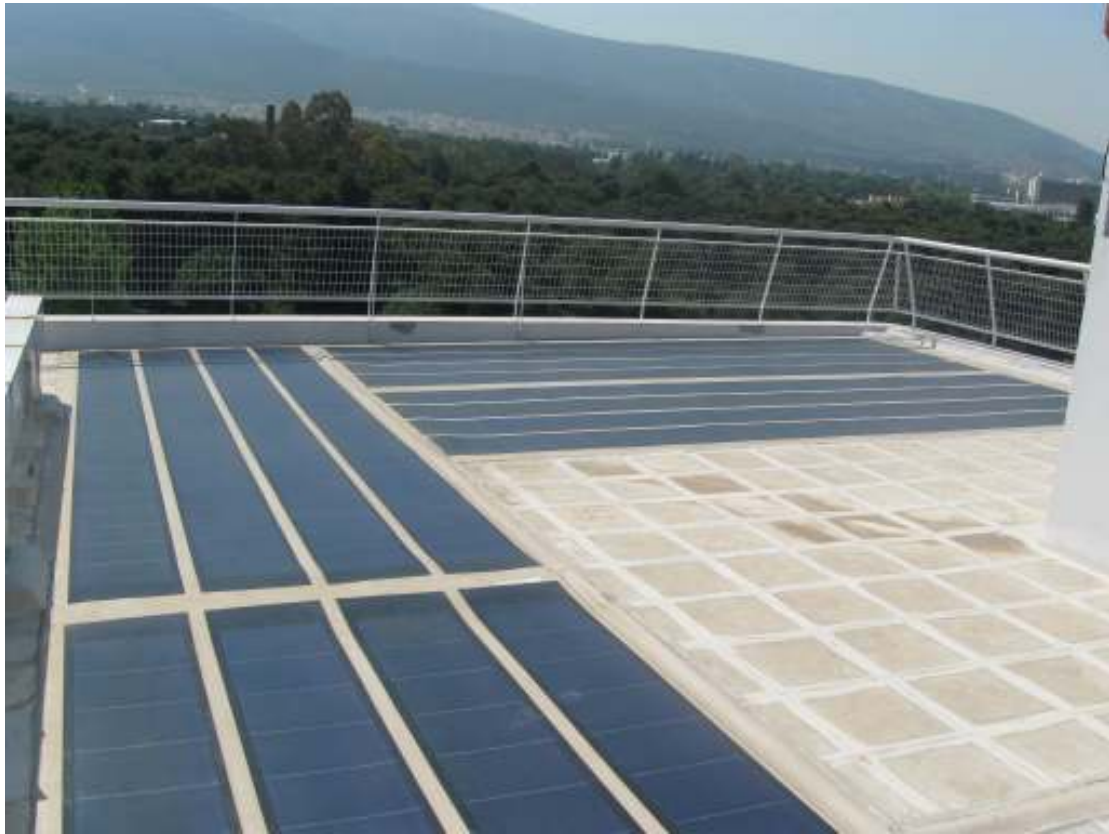
Εύκαμπτο Φ/Β σύστημα, άμορφου πυριτίου, ιδανικό για στέγες
