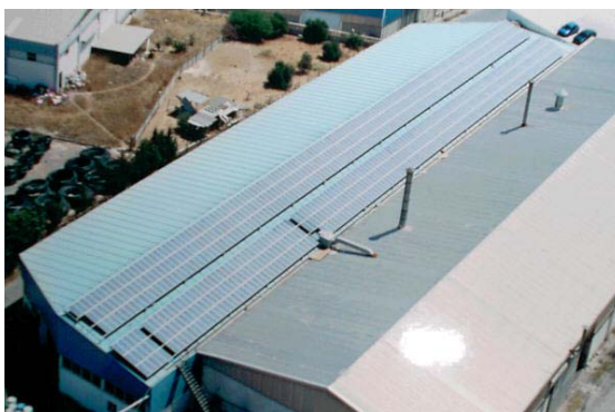
Εφαρμογή φωτοβολταϊκών σε στέγη εργοστασίου στην Κρήτη
