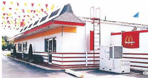
Εφαρμογή κυψελών καυσίμου σε εστιατόριο της McDonalds στη Νέα Υόρκη
