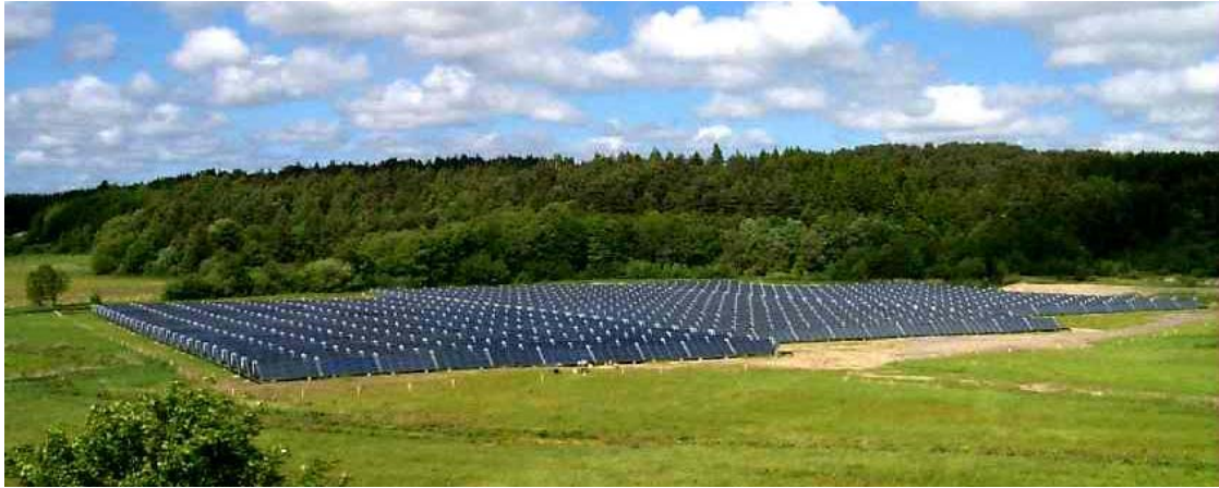
Ηλιοθερμικό σύστημα για τηλεθέρμανση στη Σουηδία
