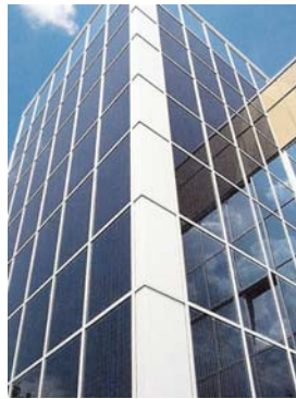
Εφαρμογή φωτοβολταϊκών σε πρόσοψη κτιρίου
