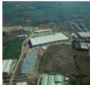
Αεροφωτογραφία του εργοστασίου στα Οινόφυτα Βοιωτίας όπου έχει εγκατασταθεί σύστημα ηλιακού κλιματισμού. Εδώ, φαίνεται το πεδίο επίπεδων ηλιακών συλλεκτών.
