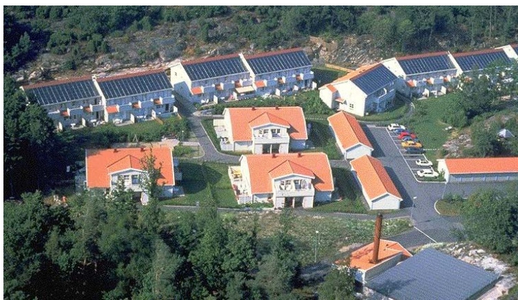
Ηλιοθερμικά συστήματα για θέρμανση χώρων στη Σουηδία
