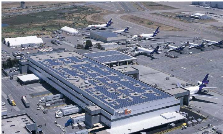
Φωτοβολταϊκά ισχύος 900 KWp στο αεροδρόμιο του Oakland στην Καλιφόρνια
