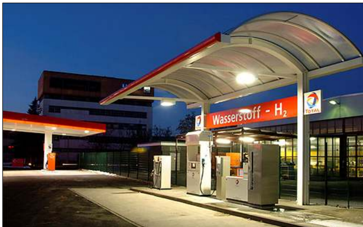
Σχήμα 3.6: Σταθμός ανεφοδιασμού υδρογόνου στο Spandau του Βερολίνου στη Γερμανία [30].
