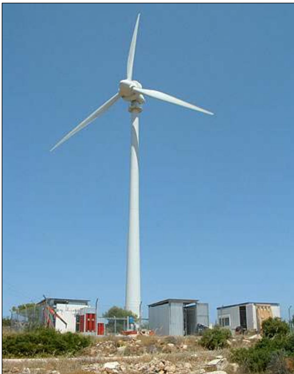
Σχήμα 7.7: Σταθμός ανεφοδιασμού υδρογόνου στο αιολικό πάρκο της Κερατέας – Αττικής στην Ελλάδα (έχει την δυνατότητα παραγωγής υδρογόνου με καθαρότητα μέχρι και 99,999% και υπό πίεση 220bar) [92].
