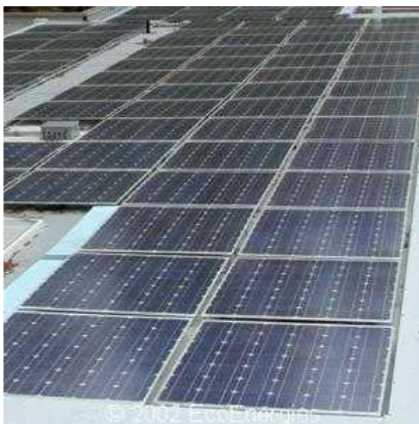
Εικόνα 12. Εγκατάσταση φωτοβολταϊκών υπομονάδων σε επίπεδη οροφή.
