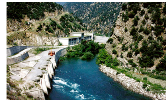
– Εικόνα 5: Υδροηλεκτρικός σταθμός - ΔΕΗ
