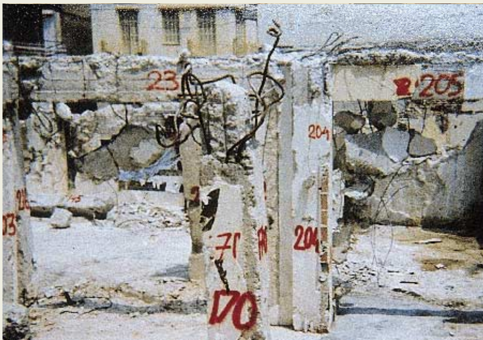
Φωτο 1: Δοκοί και υποστυλώματα του υπογείου. Διατήρηση της γεωμετρίας τους παρά την ολική κατάρρευση πάνω σ' αυτά έξι ορόφων. Εκτός από την ύπαρξη επαρκούς χώρου για επιβίωση, έχει δημιουργηθεί χώρος κατάλληλος και για εκκίνηση κατακόρυφης διεύθυνσης ανόδου. (Έρευνα αιτίων κατάρρευσης, Λουτράκι 1981)
