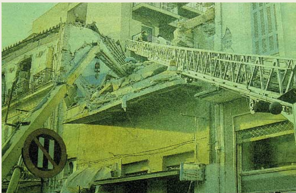
Φωτ. 16: Διάσωση παγιδευμένων από τριόροφο κτίριο στο οποίο κατέρρευσαν μόνο οι δύο ανώτεροι όροφοι. Προφανής ο κίνδυνος για τους παγιδευμένους και τους διασώστες από πιθανή κατάρρευση και του ισογείου σε ισχυρό μετασεισμό. Ο βραχίονας του γερανού αριστερά αποσκοπεί στην παρεμπόδιση της πτώσης του τοίκου του ημιερείπωμένου γειτονικού κτιρίου προς το μέρος των διασωστών. Δισαώθηκαν δύο νεαρά άτομα με ελαφρά τραύματα επειδή είχαν την ετοιμότητα να καλυφθούν κάτω από έπιπλα. (Επιχείρηση Διάσωσης, Καλαμάτα 1986)
