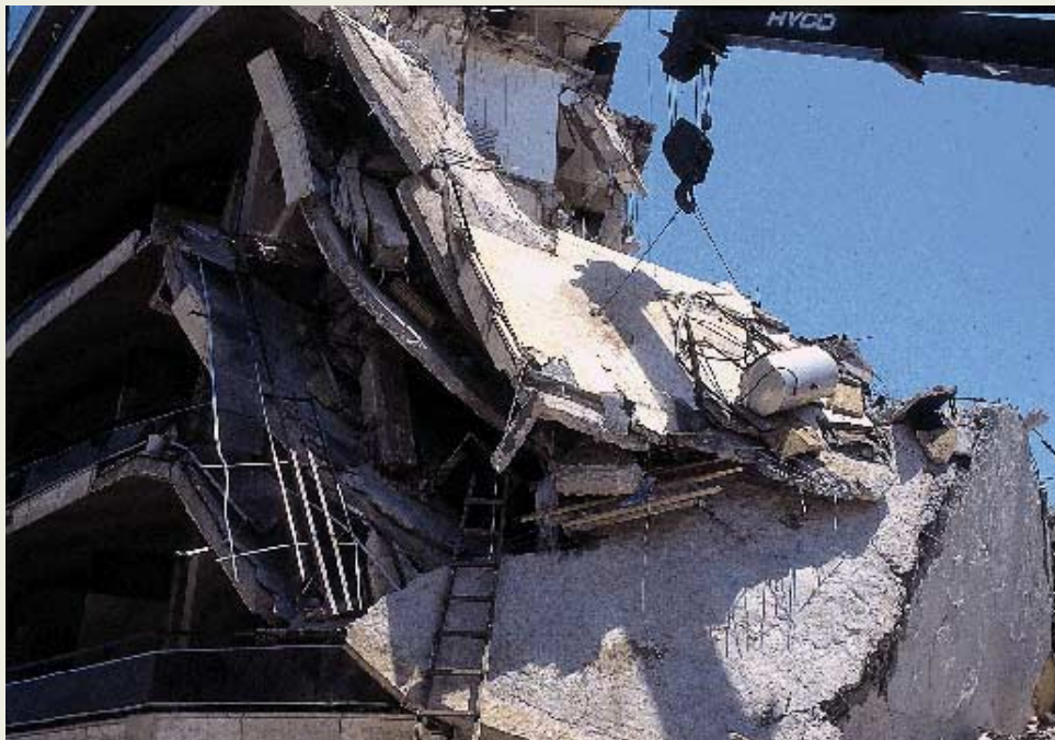
Φωτ. 11: Άρση με γερανό μεγάλου τμήματος πλάκας έντονα κεκλιμένης λόγω της μερικής κατάρρευσης του κτιρίου. Αποκοπή του τμήματος από την υπόλοιπη πλάκα του ορόφου με το κόψιμο του οπλισμού κατά μήκος των γραμμών θραύσης της πλάκας. (Αίγιο 1995)
