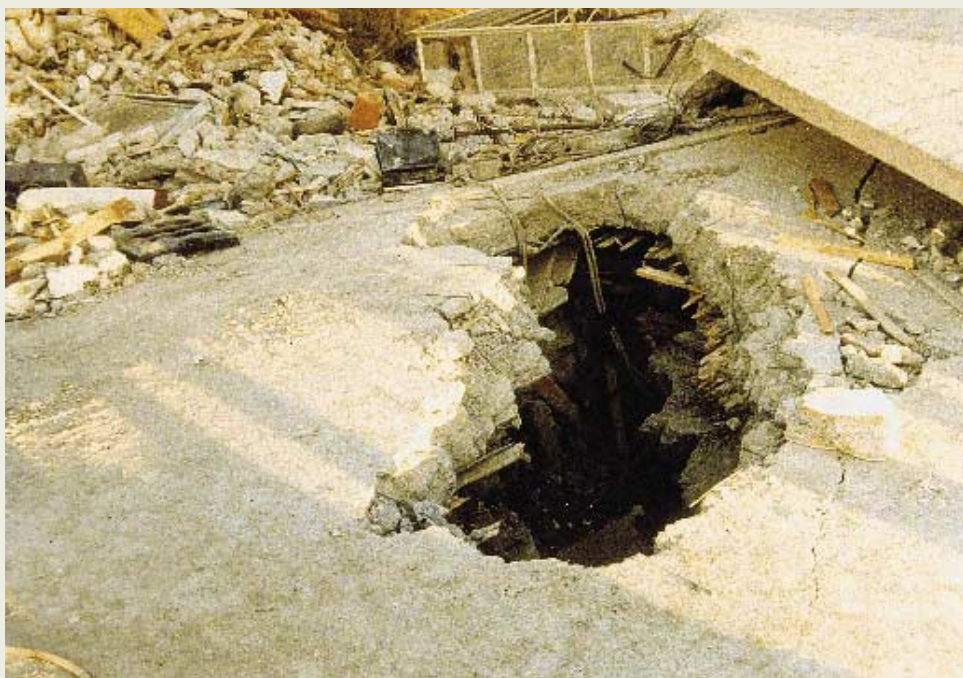
Φωτ. 12 : Άνοιγμα κατακόρυφης διείσδυσης καθόδου σε θέση που η πλάκα εμφανίζει μικρή κλίση προς το οριζόντιο επίπεδο αντίθετα με ότι συμβαίνει λίγο αριστερά. Διατηρήθηκαν δύο πλάκες και ακολούθησε οριζόντια διείσδυση με κλίση προς τα κάτω μέχρι το σημείο που υποδεικνύεται με το βέλος. Διασώθηκε βρέφος 24 ώρες μετά το σεισμό. (Διασωστική Επιχείρηση, Καραμάτα 1986)
