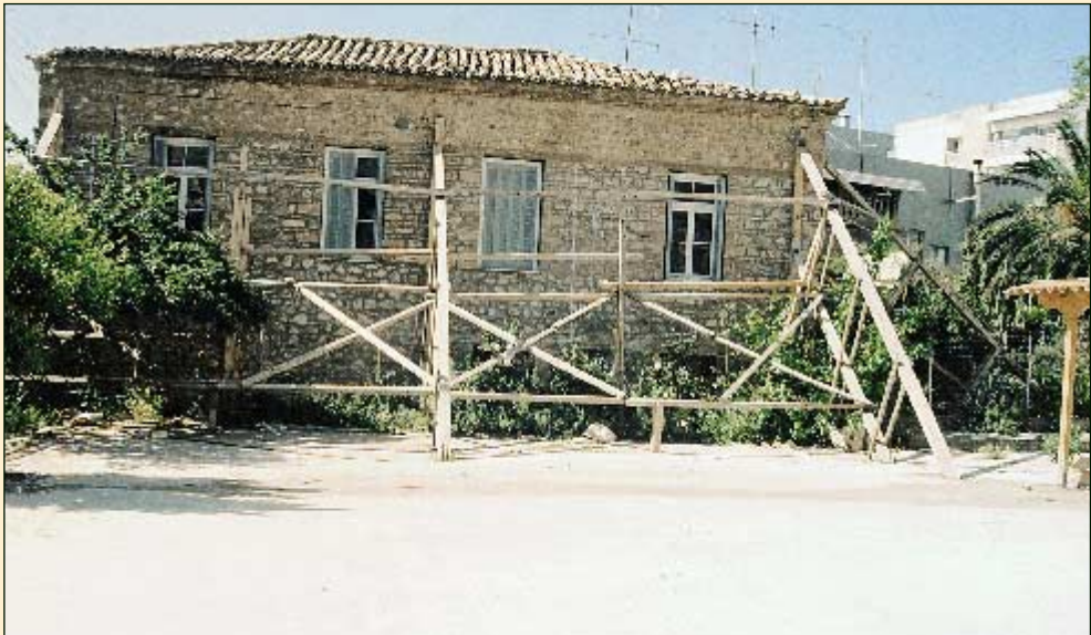
ΑΙΓΙΟ 1995 Αντιστήριξη με βιομηχανική ξυλεία σε διόροφη λιθόκτιστη οικοδομή.
