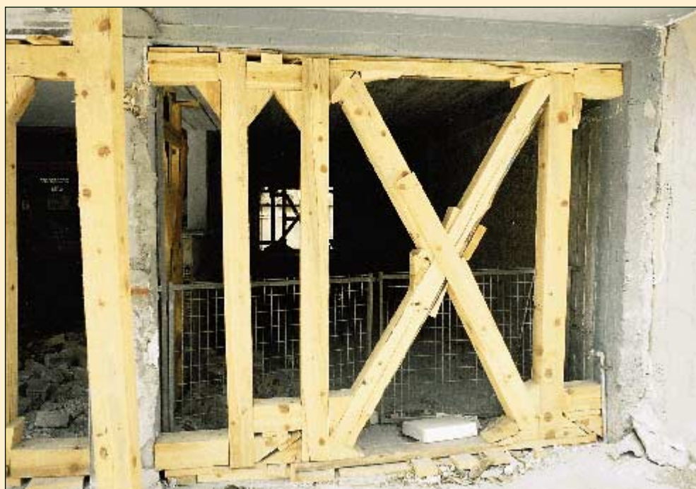
ΚΑΛΑΜΑΤΑ 1986 Υποστυλώσεις - Αντιστηρίξεις με Βιομηχανική Ξυλεία.
