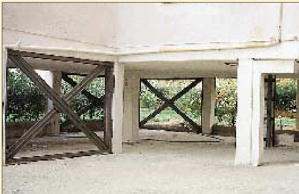
ΜΕΤΑΜΟΡΦΩΣΗ ΑΤΤΙΚΗΣ 1995 Εκτεταμένη υποσύλωση με σιδηρές διατομές (γωνιακά ισχυρά, διπλά ταύ, λάμες, χιαστί συνδέσμους κ.λπ.) σε τετραρόφη οικοδομή με σοβαρές βλάβες στα υποστυλώματα της Pilotis
