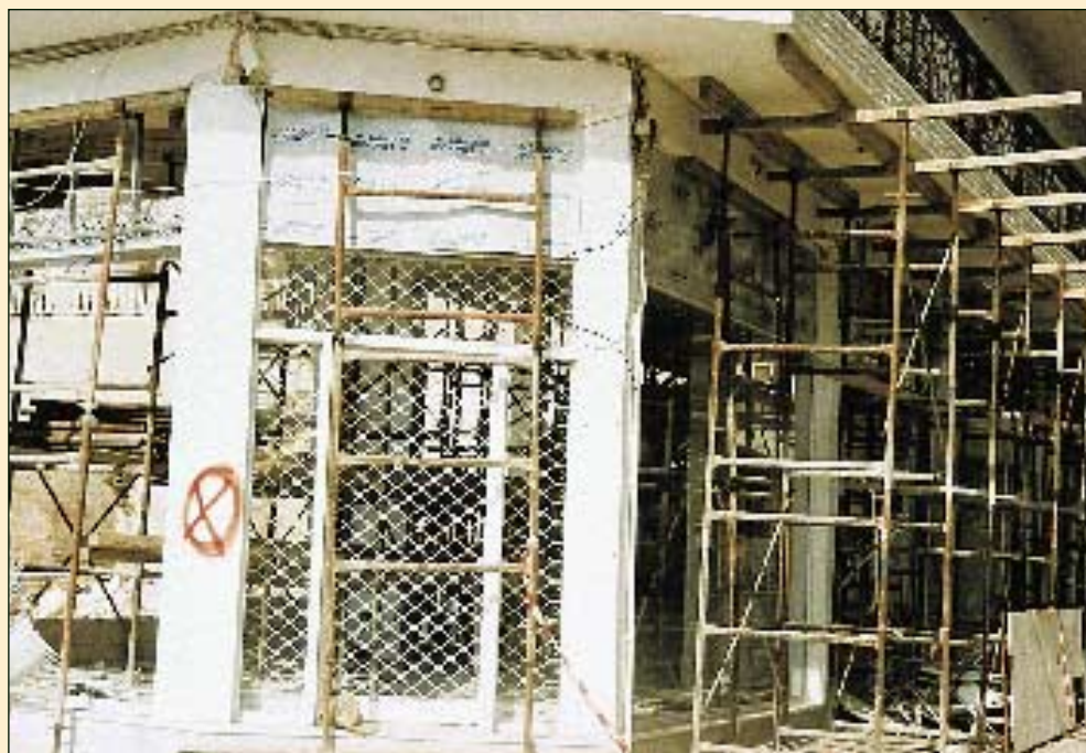
ΑΤΤΙΚΗ - ΑΝΩ ΛΙΟΣΙΑ - 1999 Υποστυλώσεις με βιομηχανικά ικριώματα, των οποίων έγινε ευρεία, αλλά όχι πάντοτε σωστή χρήση, στην περίπτωση του καταστροφικού σεισμού της Αττικής.
