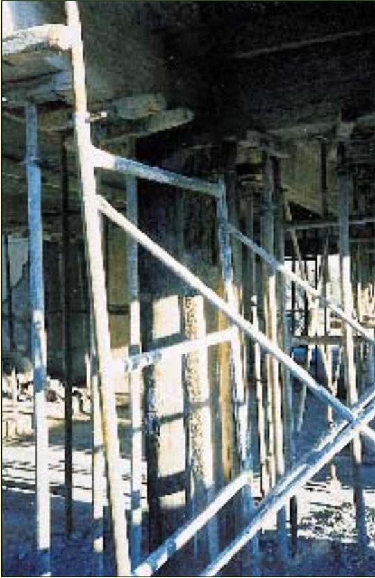
ΠΑΦΟΣ - ΚΥΠΡΟΣ 1995 Πολυώροφη οικοδομή με σοβαρές βλάβες στο τοιχείο του ανεκκυστήρα και σ' ένα υποσύλωμα, ελαφρύτερες δε, αλλά εκτεταμένες σε πολλά άλλα υποσυλώματα και δοκούς. Πρόχειρη, πυκνή υποσύλωση με μεταλλικά ικριώματα και μεμονωμένους μεταλλικούς στύλους.
