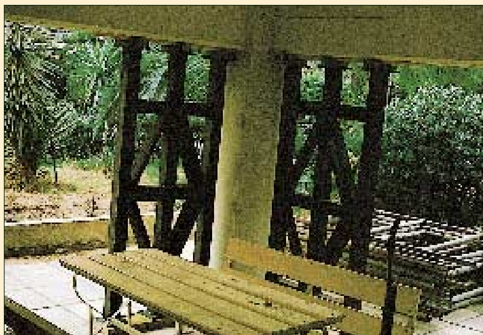
ΑΤΤΙΚΗ - ΝΕΟ ΗΡΑΚΛΕΙΟ - 1999 Εκτεταμένη υποστυλώση με κοιλοδοκούς σε Ρίλις εξαόροφης οικοδομής, με σοβαρές βλάβες σε αρκετά από τα υποστυλώματά της
