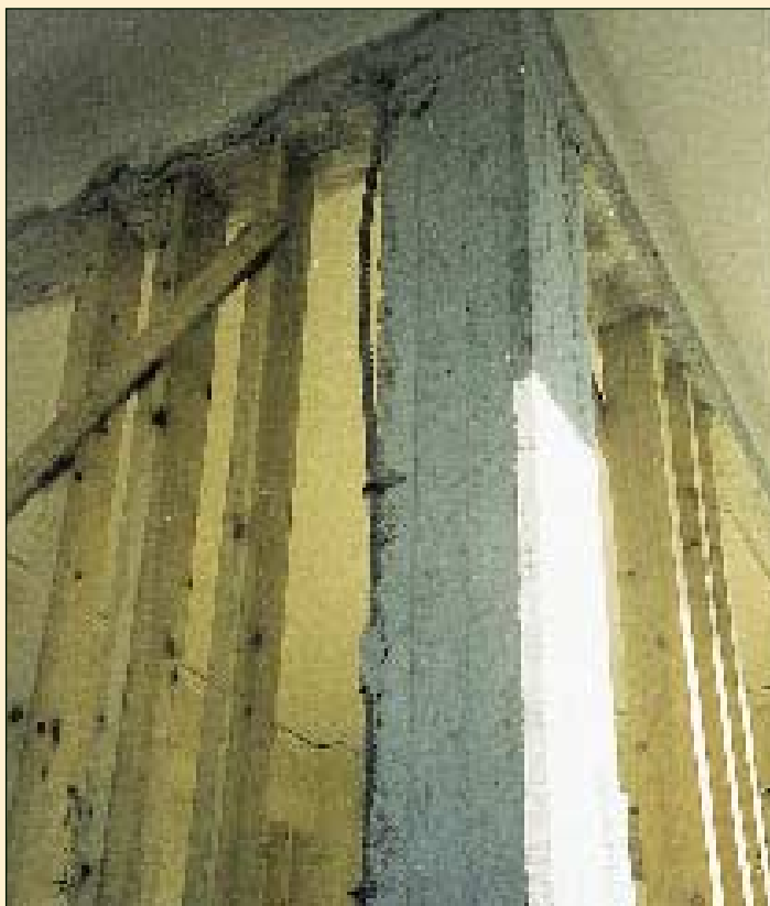
ΑΤΤΙΚΗ - ΑΝΩ ΛΙΟΣΙΑ - 1999 Υποσιλώσεις με βιομηχανική ξυλεία στα πλαίσια μεταξύ υποσιλωμάτων
