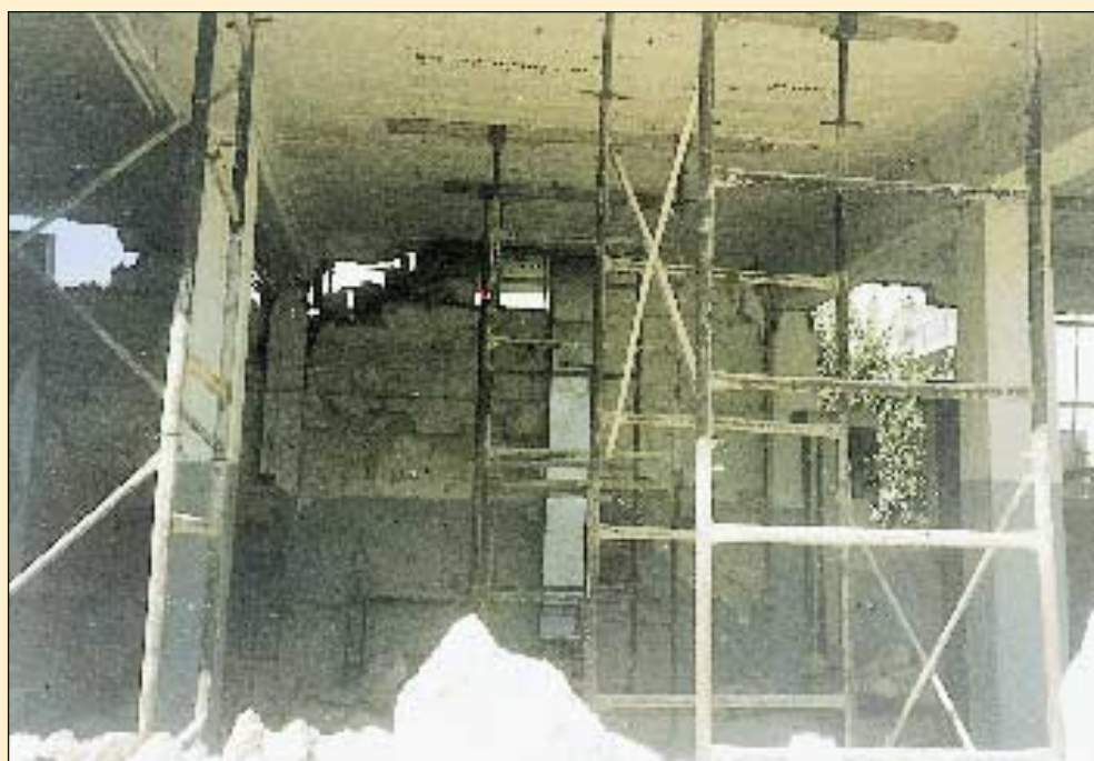
ΑΤΤΙΚΗ - ΜΕΝΙΔΙ- 1999 Μερική υποστήλωση με μεταλλικά βιομηχανικά ικρίσματα σε μαλακό όροφο με ελαφρές βλάβες.
