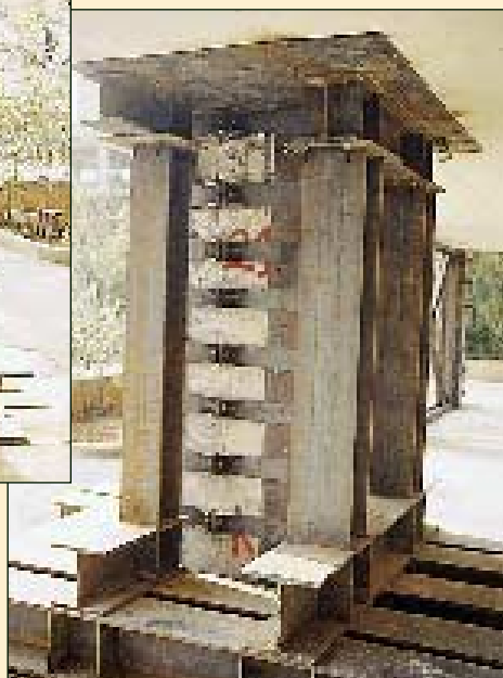
ΜΕΤΑΜΟΡΦΩΣΗ ΑΤΤΙΚΗΣ 1995 Εκτεταμένη υποσύλωση με σιδηρές διατομές (γωνιακά ισχυρά, διπλά ταύ, λάμες, χιαστί συνδέσμους κ.λπ.) σε τετραρόφη οικοδομή με σοβαρές βλάβες στα υποστυλώματα της Pilotis
