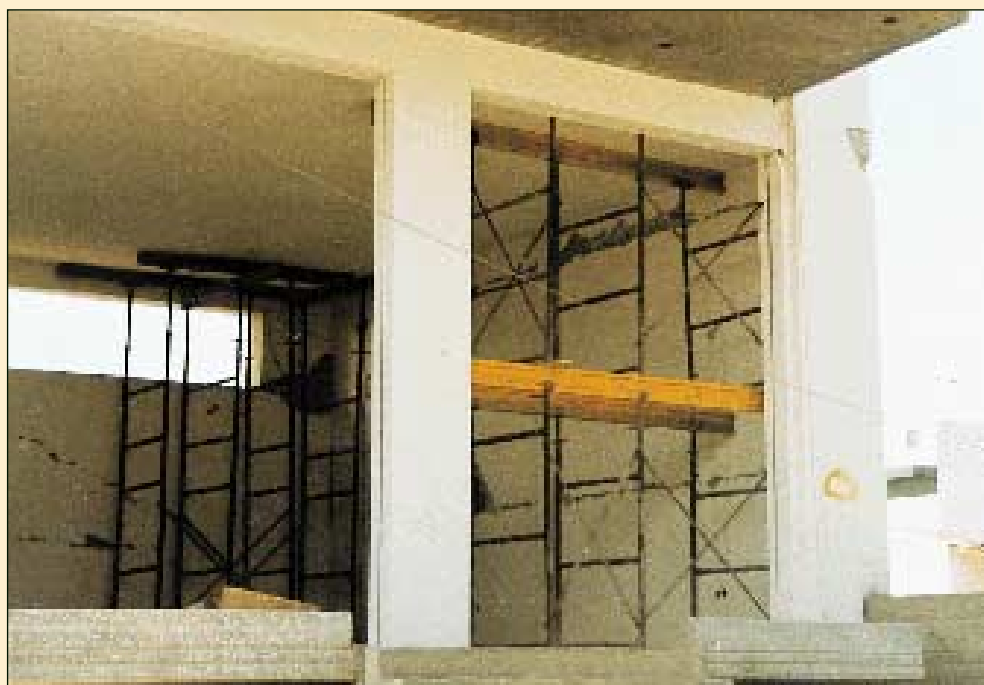
ΑΤΤΙΚΗ - ΜΕΝΙΔΙ- 1999 Μερική υποστήλωση με μεταλλικά βιομηχανικά ικρίσματα σε μαλακό όροφο με ελαφρές βλάβες.
