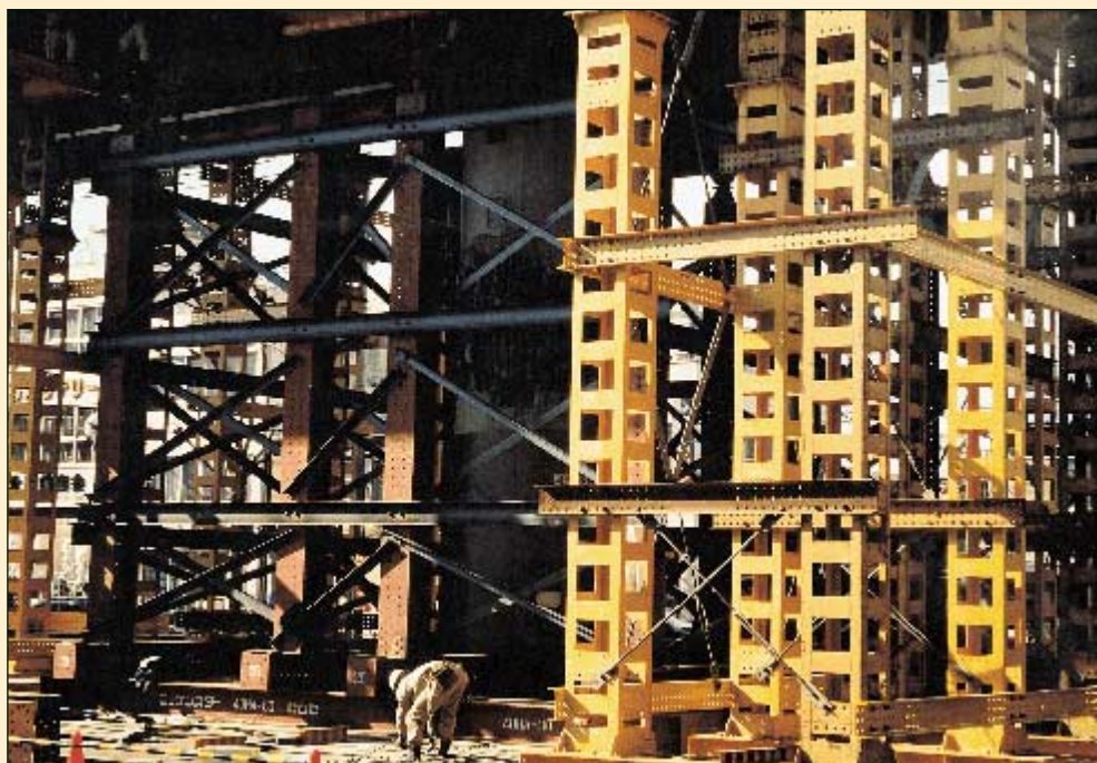
ΚΟΜΠΕ Ιαπωνίας 1995 Εκτεταμένες και βαρειές υποστυλώ- σεις με «πάσης φύσεως» σιδηρές δια- τομές, βαρέως τύπου σε μεγάλες γέφυρες της πόλης, που υπέστησαν σοβαρές βλάβες στα βάθρα τους και σε μήκος πολλών χιλιομέτρων.
