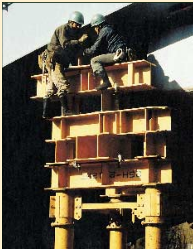
ΚΟΜΠΕ Ιαπωνίας 1995 Εκτεταμένες και βαρειές υποστυλώ- σεις με «πάσης φύσεως» σιδηρές δια- τομές, βαρέως τύπου σε μεγάλες γέφυρες της πόλης, που υπέστησαν σοβαρές βλάβες στα βάθρα τους και σε μήκος πολλών χιλιομέτρων.
