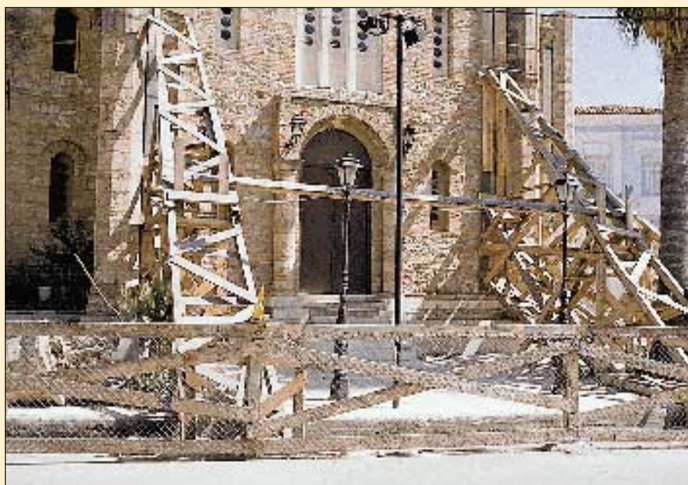
ΑΙΓΙΟ 1995 Εκτεταμένη αντιστήριξη με βιομηχανική ξυλεία στο Ναό Εισοδοίων της Θεοτόκου - Έργο Τσίλλερ,- ο οποίος υπέστη σοβαρές βλάβες.
