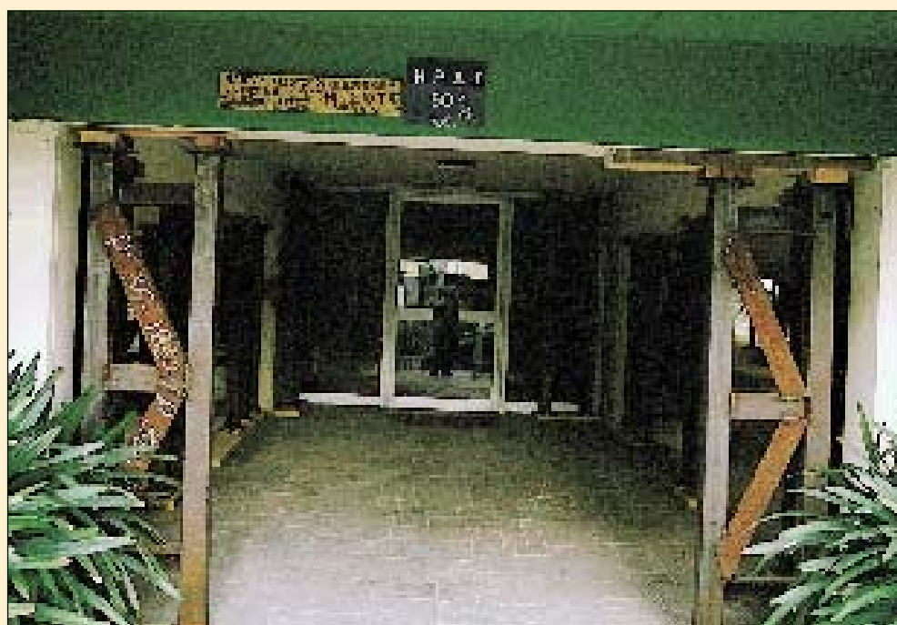
ΑΤΤΙΚΗ - ΝΕΟ ΗΡΑΚΛΕΙΟ - 1999 Εκτεταμένη υποστυλώση με κοιλοδοκούς σε Ρίλις εξαόροφης οικοδομής, με σοβαρές βλάβες σε αρκετά από τα υποστυλώματά της
