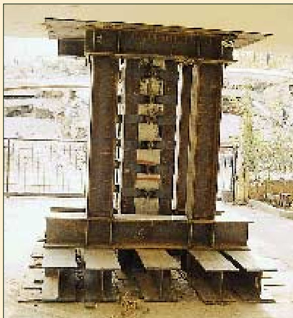
ΜΕΤΑΜΟΡΦΩΣΗ ΑΤΤΙΚΗΣ 1995 Εκτεταμένη υποσύλωση με σιδηρές διατομές (γωνιακά ισχυρά, διπλά ταύ, λάμες, χιαστί συνδέσμους κ.λπ.) σε τετραρόφη οικοδομή με σοβαρές βλάβες στα υποστυλώματα της Pilotis
