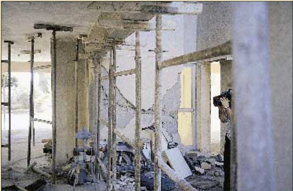
ΠΑΦΟΣ - ΚΥΠΡΟΣ 1995 Πολυώροφη οικοδομή με σοβαρές βλάβες στο τοιχείο του ανεκκυστήρα και σ' ένα υποσύλωμα, ελαφρύτερες δε, αλλά εκτεταμένες σε πολλά άλλα υποσυλώματα και δοκούς. Πρόχειρη, πυκνή υποσύλωση με μεταλλικά ικριώματα και μεμονωμένους μεταλλικούς στύλους.
