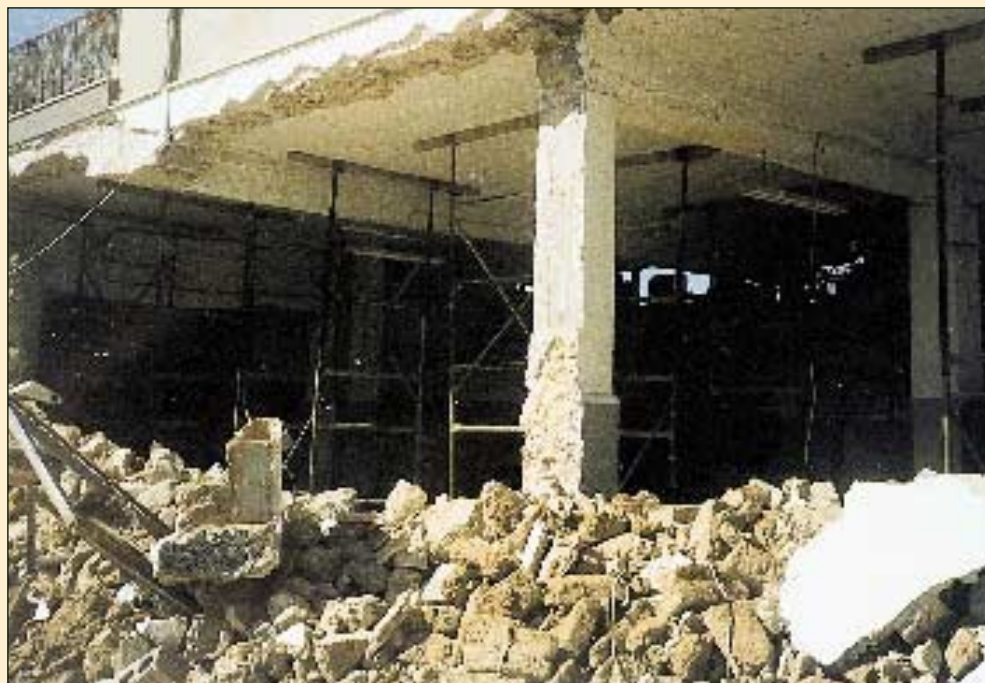
ΑΤΤΙΚΗ - ΑΝΩ ΛΙΟΣΙΑ - 1999 Υποστυλώσεις με βιομηχανικά ικριώματα, των οποίων έγινε ευρεία, αλλά όχι πάντοτε σωστή χρήση, στην περίπτωση του καταστροφικού σεισμού της Αττικής.
