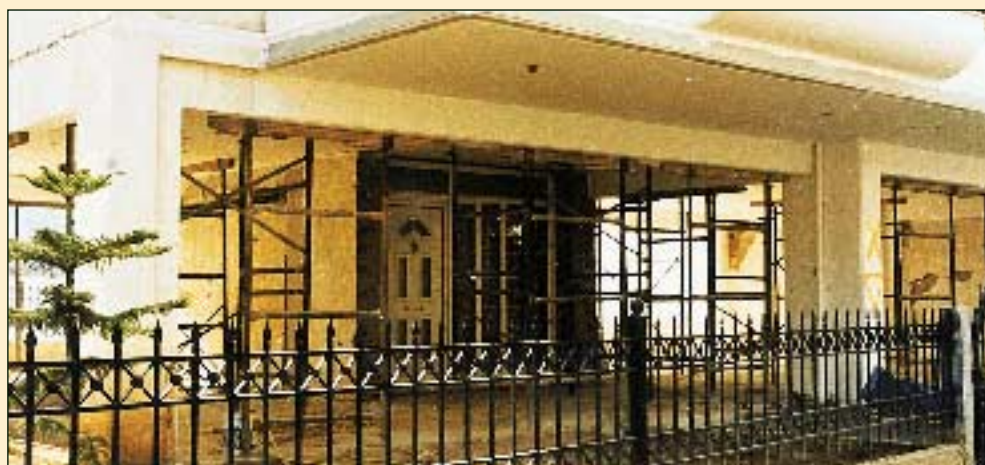
ΑΤΤΙΚΗ - ΑΝΩ ΛΙΟΣΙΑ - 1999 Υποσιλώσεις με βιομηχανικά ικρίωματα σε διόροφη οικοδομή με Pilotis και ελαφρές ζημιές
