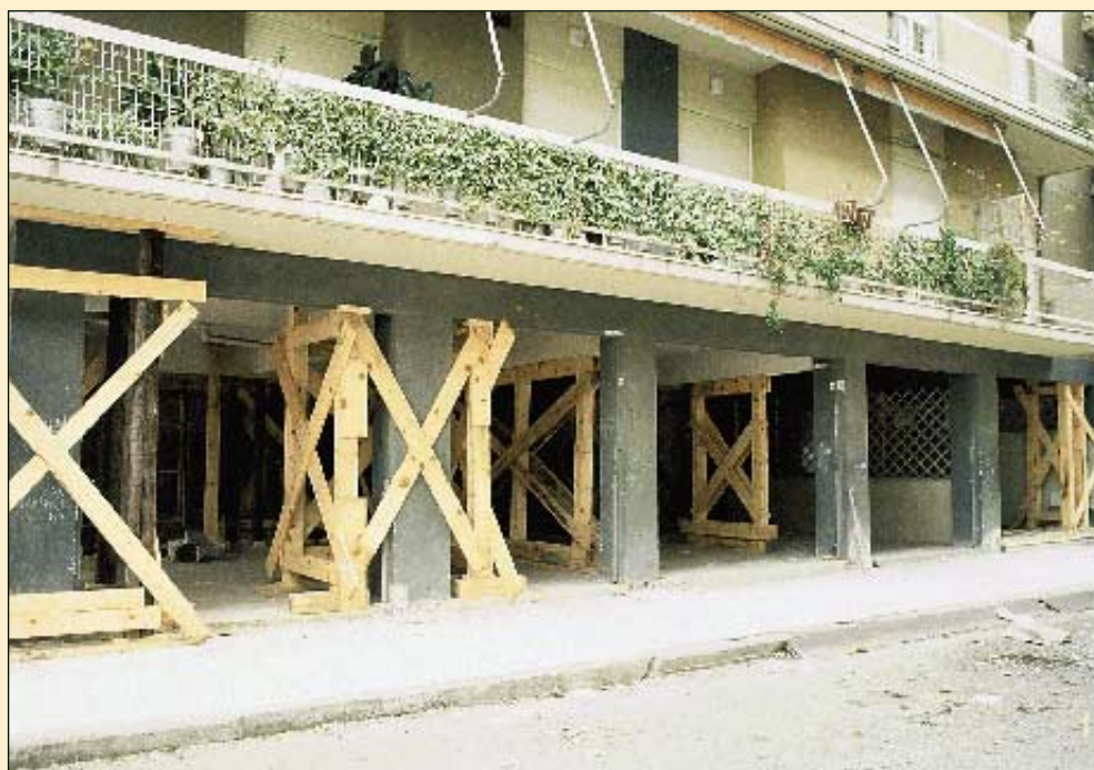
ΚΑΛΑΜΑΤΑ 1986 Υποστυλώσεις - Αντιστηρίξεις με Βιομηχανική Ξυλεία.
