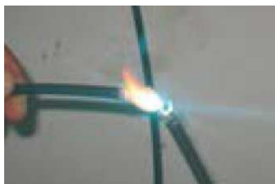
Εικόνα 12 : Ηλεκτρικό τόξο σε ένα κύκλωμα PV.
