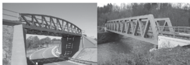
Εικόνες 3 και 4: Παραδείγματα γεφυρών με τραβέρσες (truss bridges). Πηγή: Railway bridges. Top Con Service [online]. 1992-2011 [cited. 02.19.2012]. Διαθέσιμη από την ιστοσελίδα: http://www.topcon.cz/reference/railway-mosty.htm
